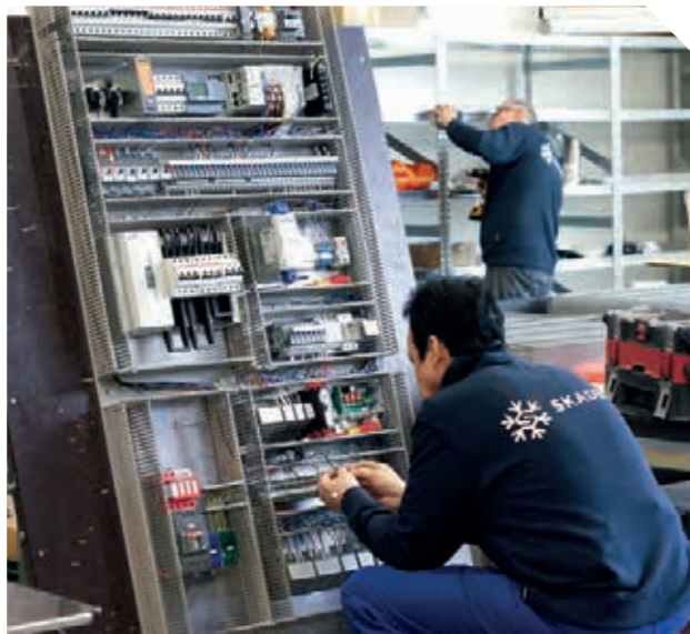
Bygging av styreskap
